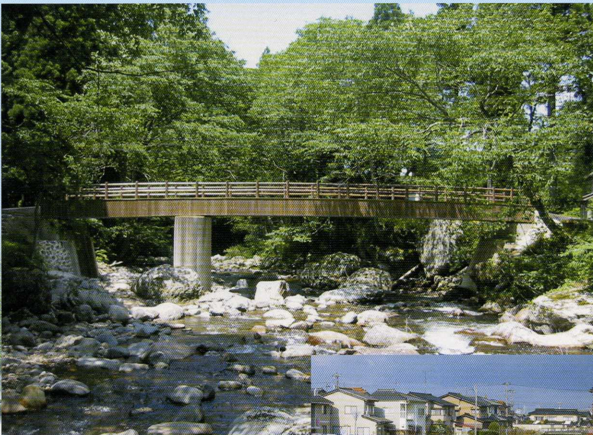
久保橋上部工架替工事 橋長24.80m(7.40+17.40) 石川県小松市 (平成16年5月架)
