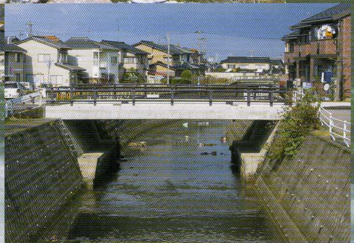
太郎田橋上部工架替工事 橋長13.10m 石川県金沢市 (平成16年9月架)
