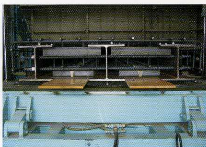
実験桁製作状況
